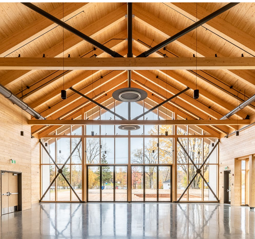
Mur-rideau en bois, Base de plein air de Sainte-Foy, Québec (Photo: Manophotographe)
