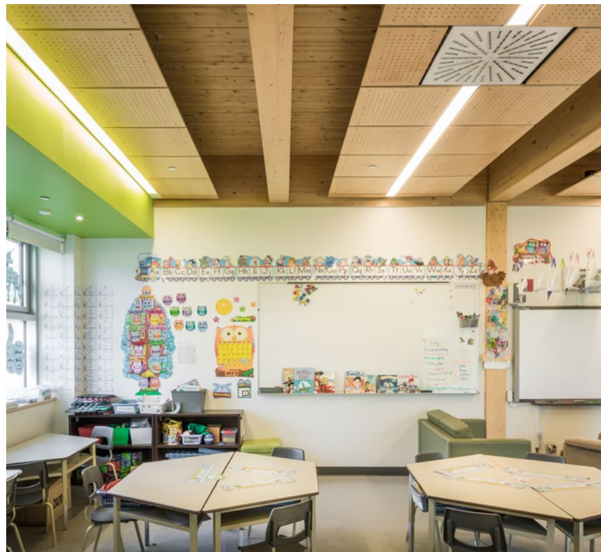
Plafonds acoustiques en bois perforé, école de l'Everest, Québec (Photo : Joël Gingras)
